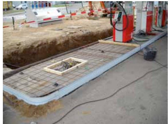
Förlängning av befintlig pumpörefug
